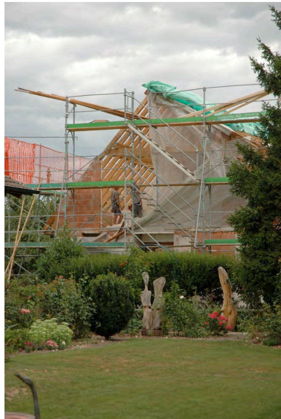
Aufrichtung des Dachstockes
