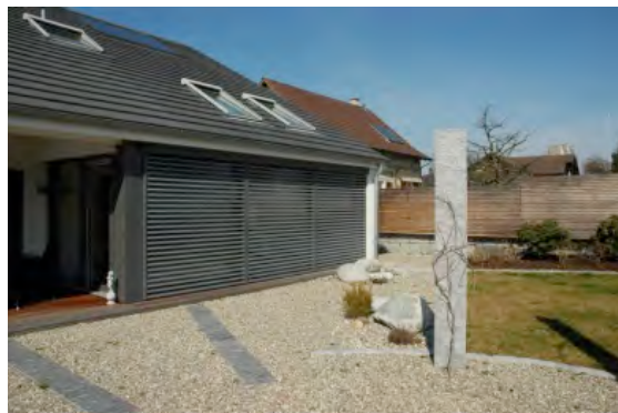
Anbau mit Schiebetüren
